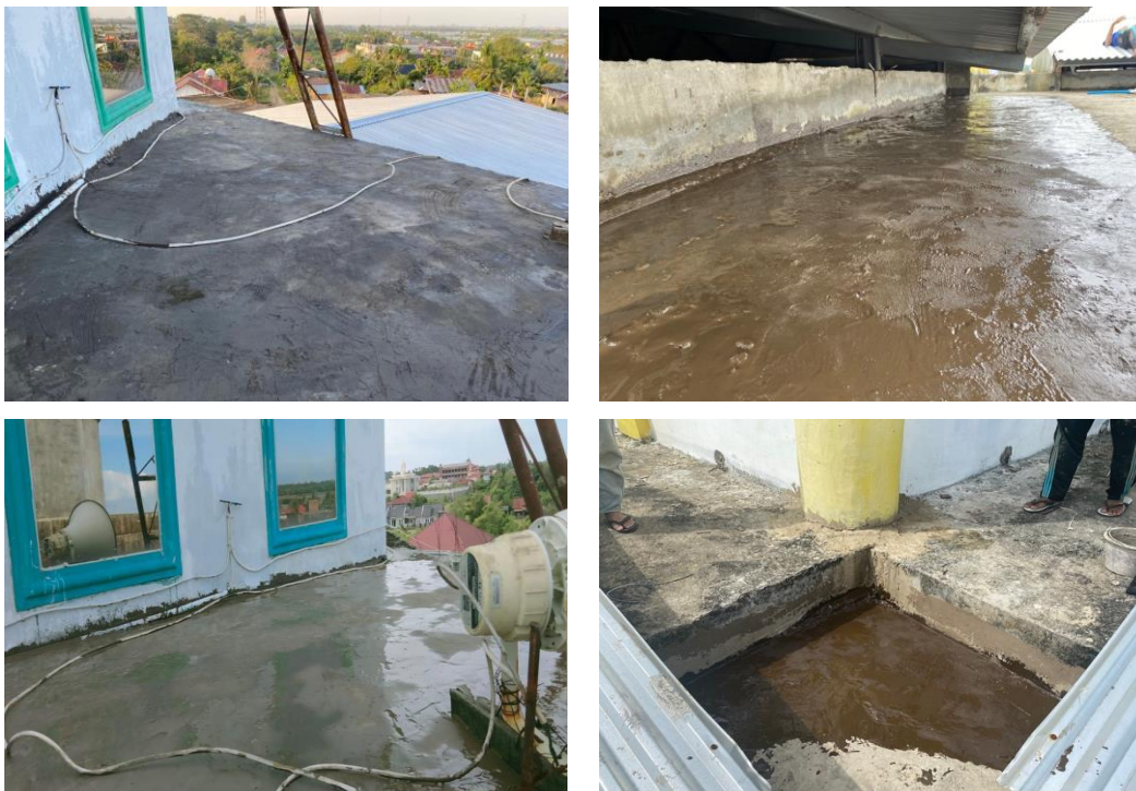
Gambar 5. Kondisi akhir permukaan atap setelah pengaplikasian waterproofing coating berbasis geopolimer
