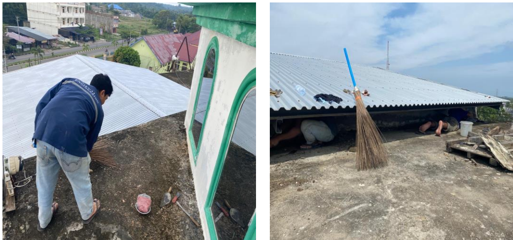
Gambar 3. Persiapan permukaan sebelum penggunaan waterproofing coating berbasis geopolimer
