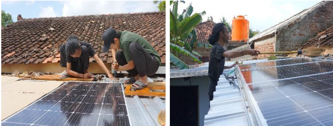
Gambar 2. Pembersihan panel surya dan perbaikan sambungan kelistrikan.
