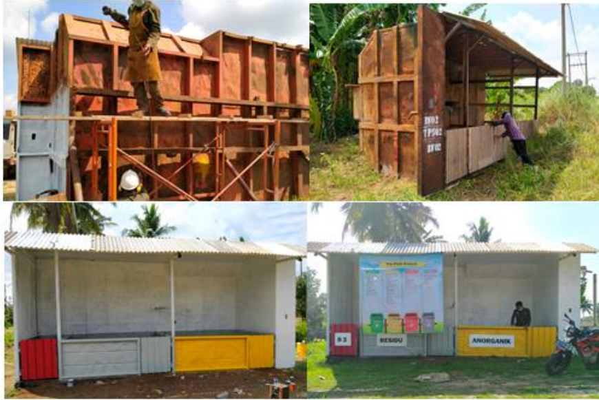
Gambar 6. Pembuatan Tempat Pembuangan Sampah Komunal dari Bak Truk bekas pada setiap RW dengan pembatas/ruang B3, Residu dan Anorganik
