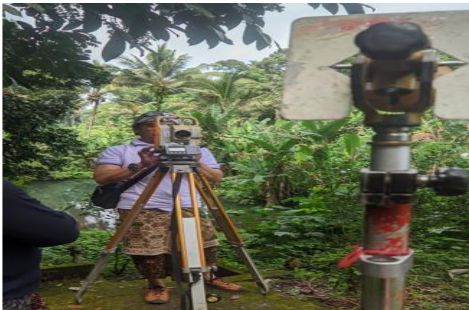
Gambar 4. Persiapan Pekerjaan Pengukuran
