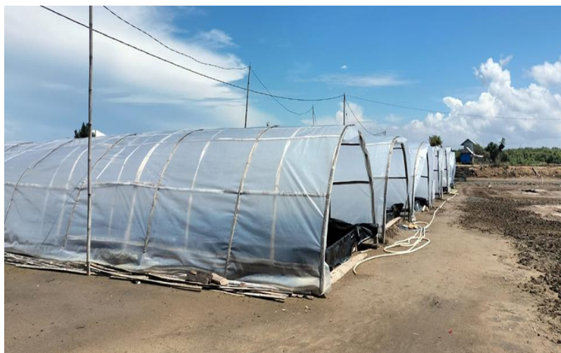
Gambar 2. Tunnel garam berbentuk terowongan dari rangka bambu dan pada bagian bawah terdiri dari kolam garam beralaskan plastik sebagai tempat penguapan
