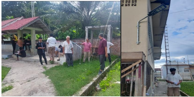
Gambar 9. Kegiatan pemasangan PJU
