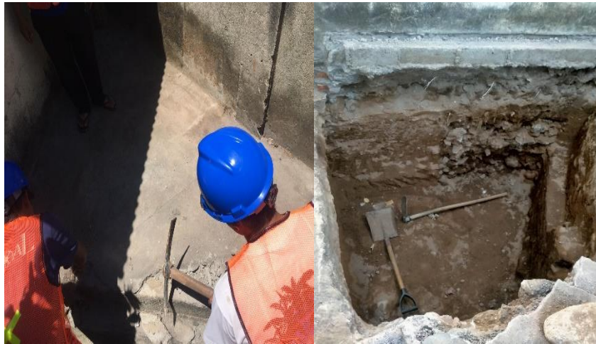
Gambar 4. Pekerjaan Galian Tanah
