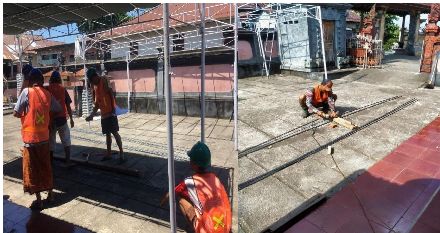
Gambar 3. Pekerjaan Pembesian Dalam pekerjaan Beton
