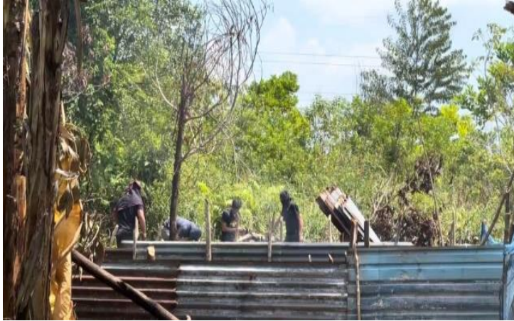
Gambar 1. Dokumentasi Pembuatan & Perbaikan Kolam
