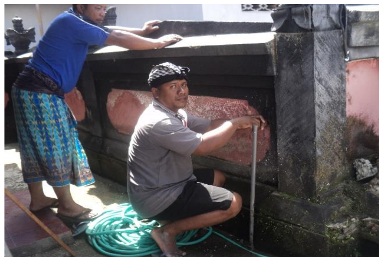
Gambar 7. Kegiatan Perbaikan Instalasi Air di Sanggah Dadia Kelod kauh
