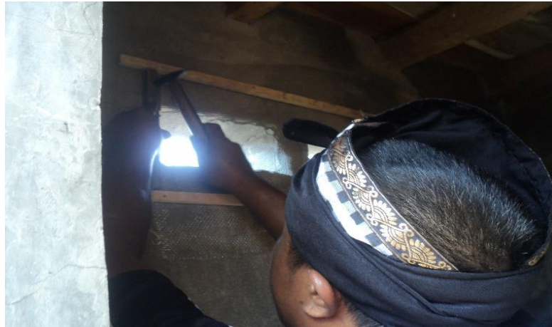
Gambar 6. Kegiatan Perbaikan Instalasi Listrik di Sanggah Dadia Kelod kauh
