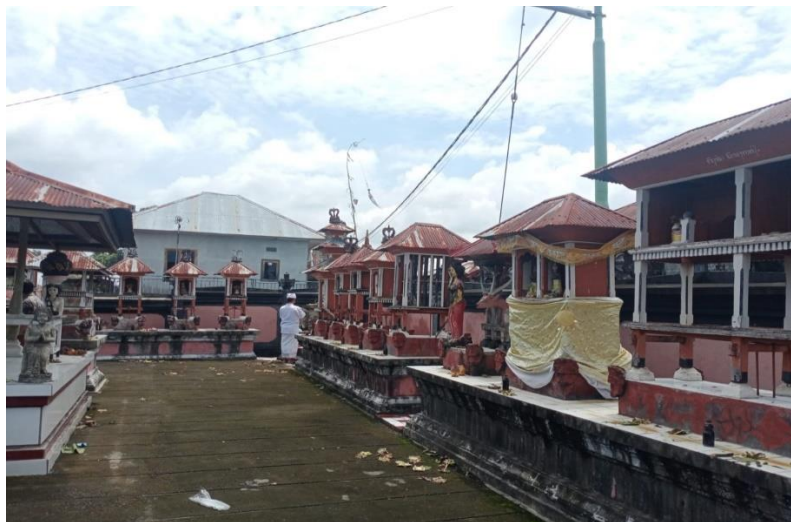
Gambar 2. Kondisi Penempatan Pelinggih
