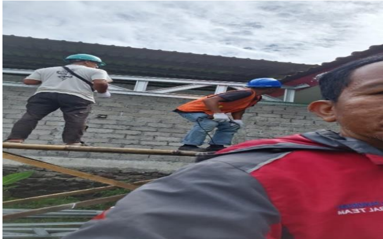
Gambar 5. Pemasangan Kap dan Atap
