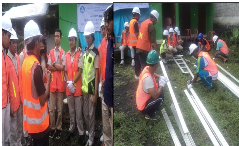
Gambar 4. Pelatihan Pembuatan Rangka Atap Baja Ringan
