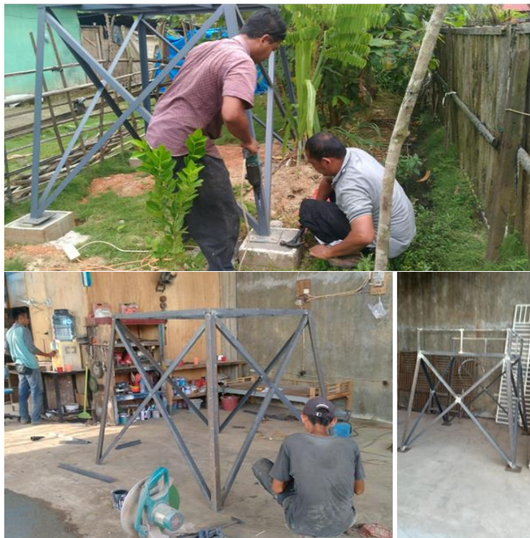
Gambar 6. Fabrikasi dan pemasangan menara untuk reservoir
