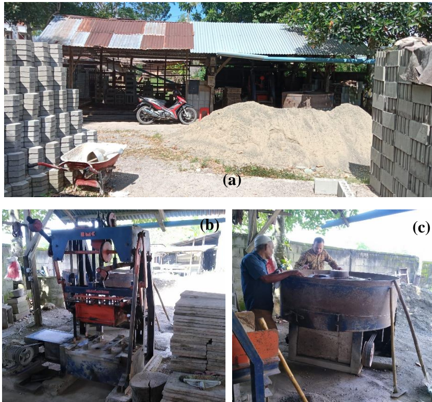
Gambar 1. Kondisi fasilitas yang dimiliki mitra (a) tempat produksi, (b) alat press batako dengan penggerak diesel 8 PK / dinamo 3 hp, (c) pengaduk mortar kapasitas 0,25 m 3 dengan tenaga penggerak 5,5 hp.
