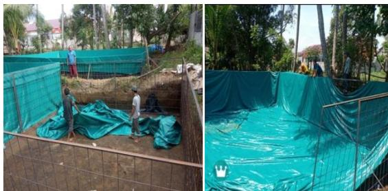
**Gambar 4.** Pemasangan Kerangka besi dan terpal disekeliling Kolam
