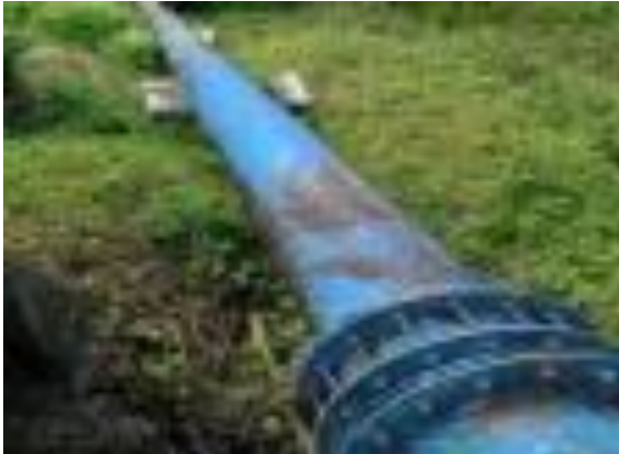
Gambar 5. Pipa pesat PLTMH Tingkem
