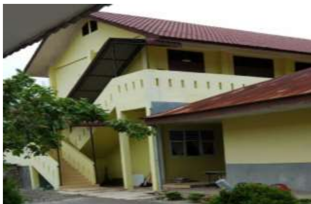
Gambar. 1 Keadaan Bangunan Laboratorium Kimia di SMAN 1 Langsa
