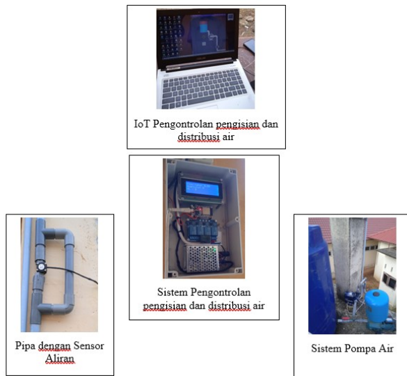
Gambar 6. Hasil instalasi sistem pengontrolan pengisian dan distribusi air berbasis IoT pada SMK Negeri 5 Lhokseumawe.
