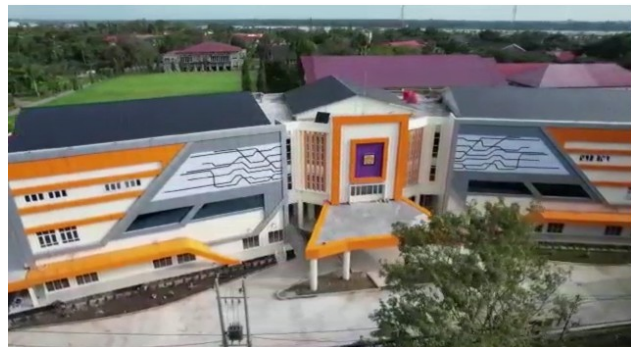
Gambar I.1. Gedung Jurusan TIK PNL Dengan Tandon Air di Atas Atap lantai 3
