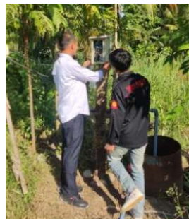
b. Pemasangan kontroler
