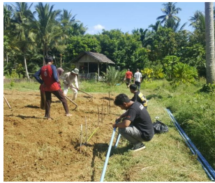
a. Pemasangan pipa
