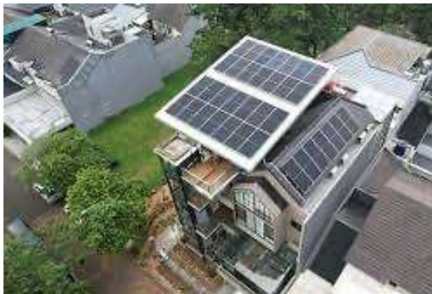
Gambar 2. Sistem solar panel koneksi rumah tinggal [5]
