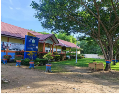
Gambar 1. Gedung SMK Negeri 1 Nibong
