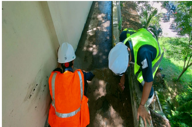
Gambar 6. Pengaplikasian Geocoating Pada Gedung Jurusan Teknik Sipil (JTS)
