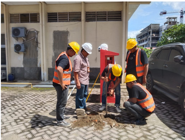
Gambar 4. Proses pemasangan rambu
