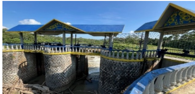
Gambar 2. Pintu Bendungan Alue Ubay tampak samping
