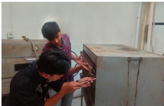
Gambar 5. Pengenalan pada alat-alat oven dan kompor gas dan simulasi perawatan service berkala
