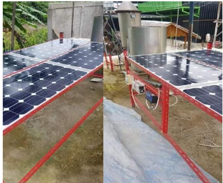
Gambar II.1 Perakitan solar panel dan boiler
