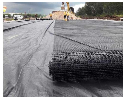
Gambar 3 Pemasangan Geogrid pada perkerasan jalan
