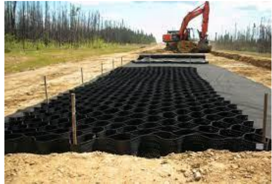
Gambar 1 Geogrid pada lapisan jalan
