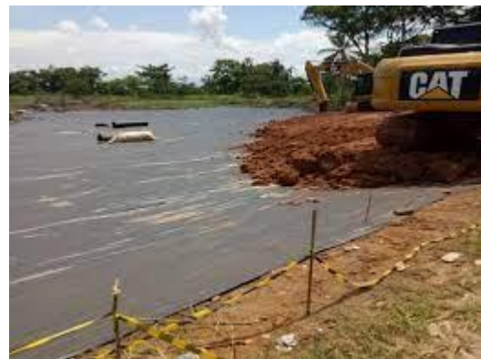
Gambar 2 Geotekstil pada lapisan jalan
