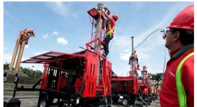
Gambar 20. Portable Base Station saat instalasi Bencana Gunung Kelud 2014
