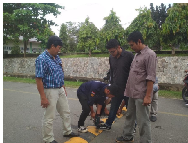
Gambar 2. Pemasangan Speed Bump
