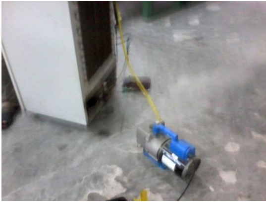
Gambar 5 Proses Pemvacuman Sistem pemipaan pada kulkas
