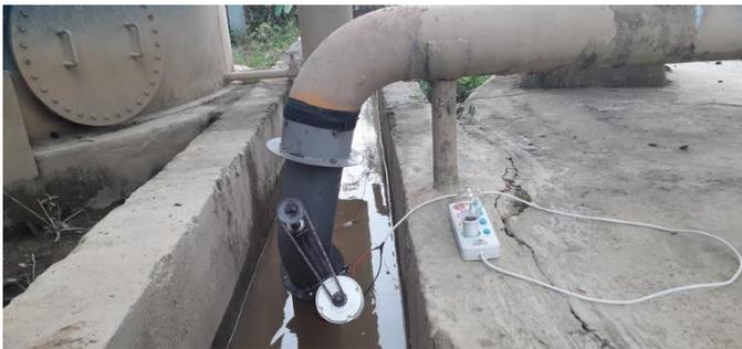
Gambar 12: Hasil instal turbin pada lokasi
