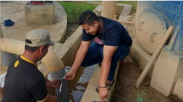
Gambar 11: Proses perbaikan komponen poros turbin
