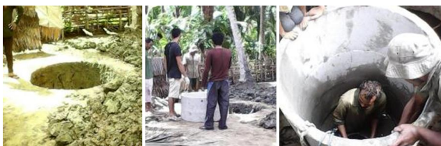
Gambar 3. Pengerjaan reservoir
