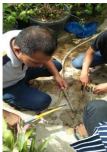
Gambar 4 Pemasangan Sprinkler
