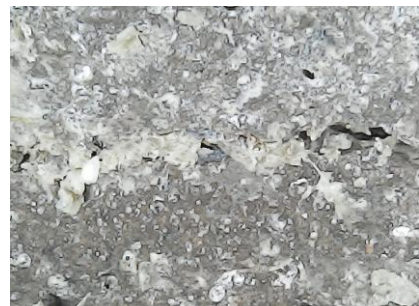
Gambar 16. Permukaan Mortar Optimum Pengujian UPV pada Umur 30 Hari
