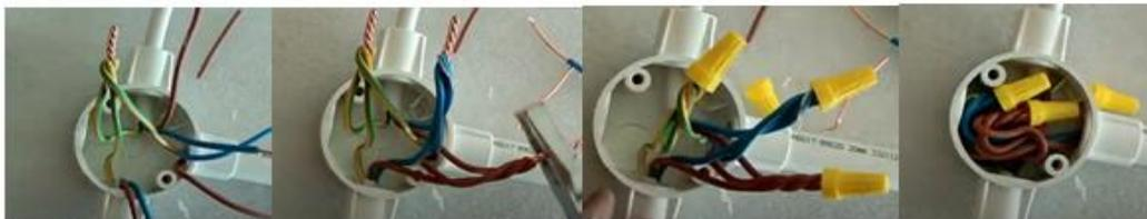
Gambar 8 Kabel instalasi listrik yang telah rapi menggunakan lasdop
