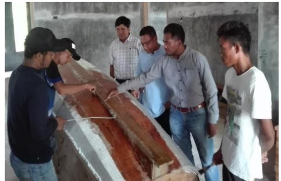
Gambar 3.3. Proses pelapisan Perahu Triplek menggunakan Resin Polyester serat gelas.
