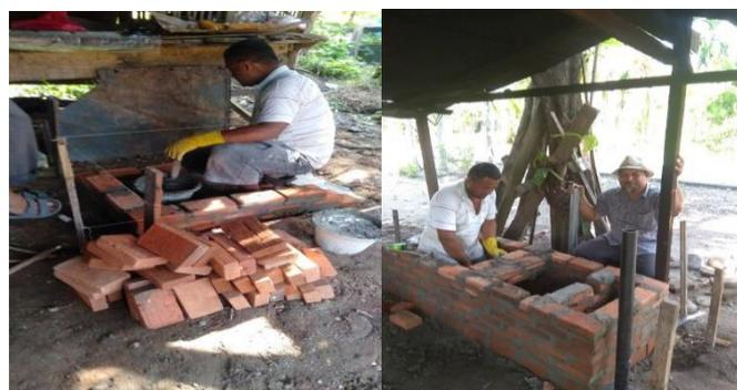
Gambar 4. Proses pembuatan tungku hemat energi
