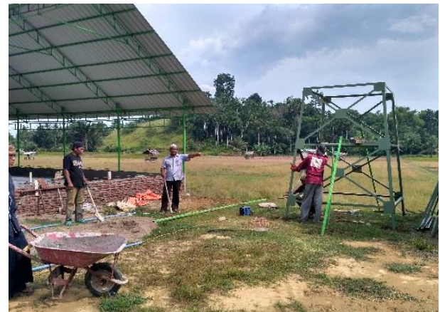
Gambar 4. Proses pemasangan tower
