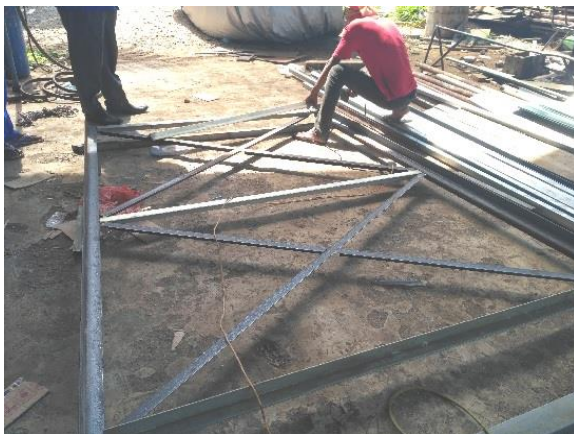
Gambar 3. Proses fabrikasi tower
