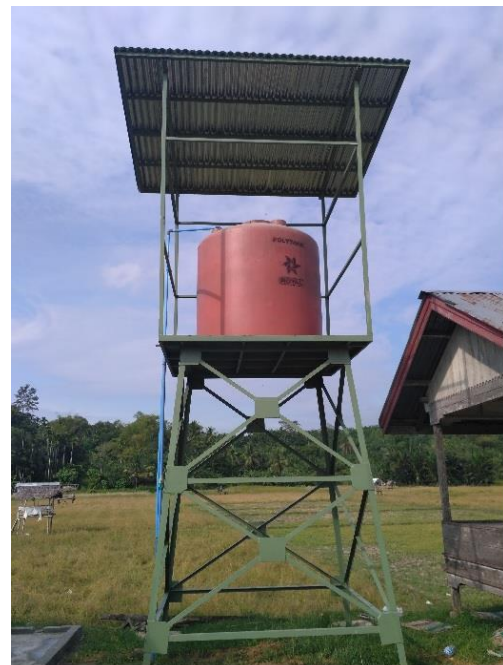
Gambar 5. Tower yang telah selesai dibangun
