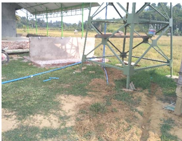
Gambar 6. Proses perpipaan di lokasi mitra
