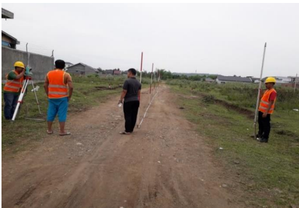
Gambar 6. Kegiatan pengukuran garis as/tengah jalan menggunakan theodolite
