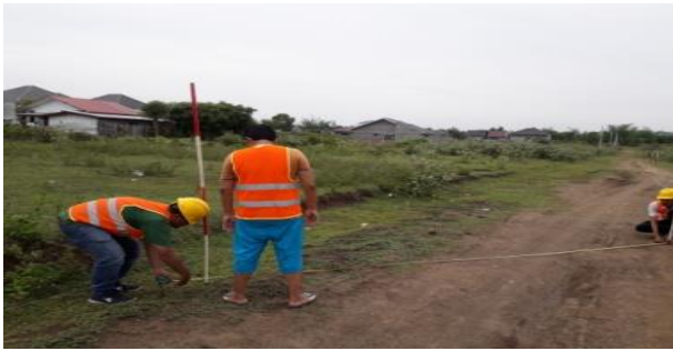
Gambar 3. Penyetingan dan pengukuran garis as/tengah jalan desa
