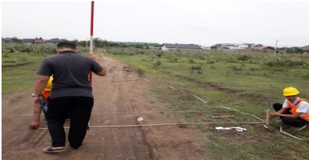
Gambar 4. Pengecekan garis tengah/as jalan desa menggunakan alat ukur sederhana
