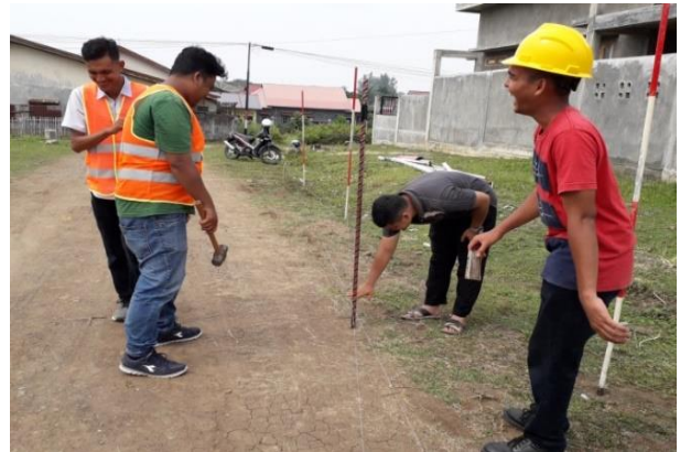
Gambar 13. Penyetingan titik pertemuan point kurva alinyemen horizontal
