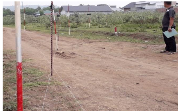
Gambar 12. Penentuan titik-titik point kurva alinyemen horizontal di lapangan
