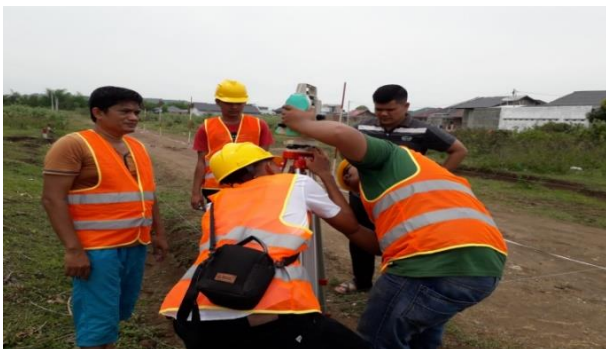
Gambar 5. Kegiatan penyetingan theodolite
