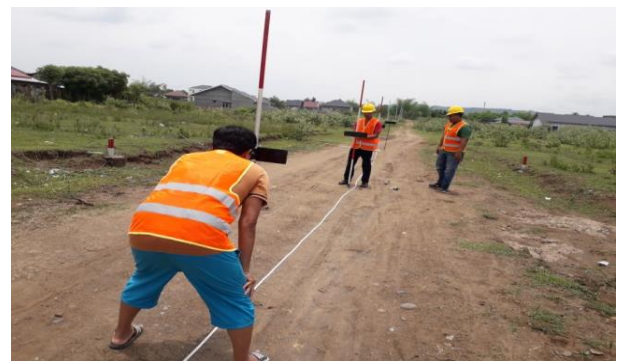
Gambar 24. Penyetingan alinyemen vertikal dan badan jalan
