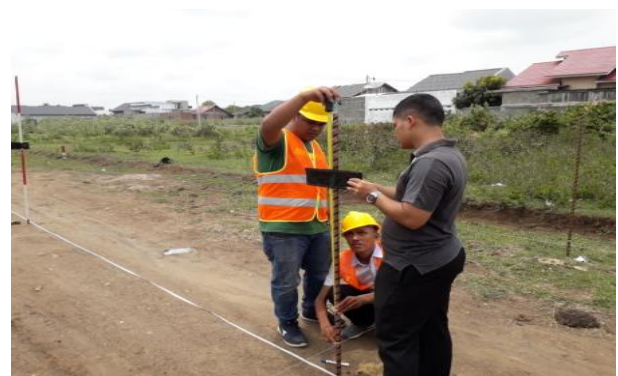
Gambar 25. Pengukuran ketinggian muka tanah asli
