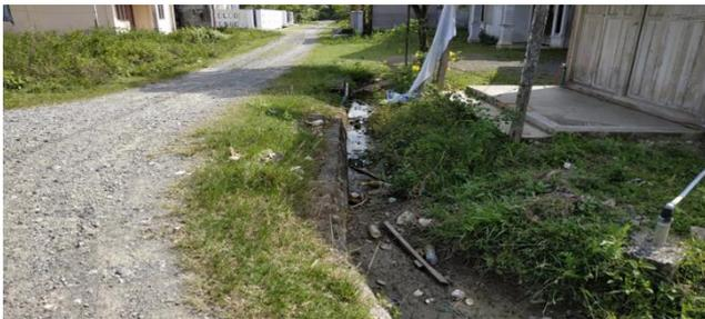
Gambar 1 Sedimentasi pada saluran
