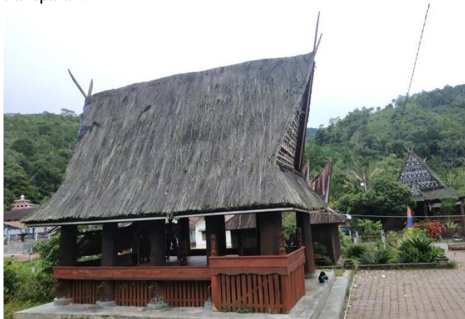
Gambar 3. Rumah Adat Sopo Godang tampak samping, terlihat jelas tidak memiliki dinding.
