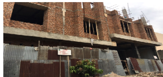
Gambar 4. RUKO B , Lokasi Jalan Alfalah 4 Kecamatan Medan Timur
