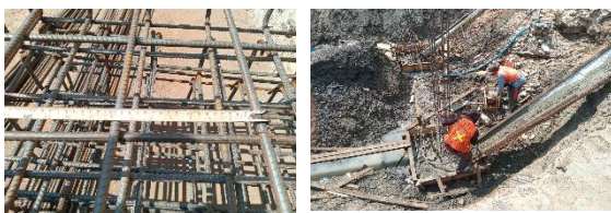
Gambar 1. Pekerjaan footplate
