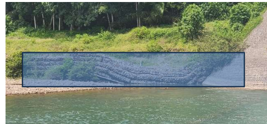
Gambar 1. Kondisi eksisting sayap hilir kanan
