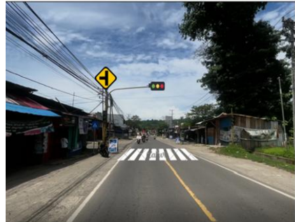
Gambar 3. Segmen 55 setelah perbaikan
