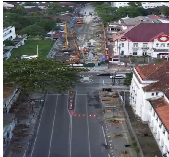
Gambar1. Persimpangan Jalan H. M. Yamin sebelum adanya underpass
