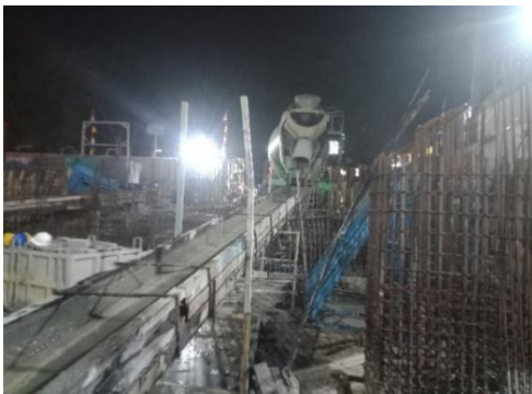
Gambar 11. Pengecoran penggabungan tiang pancang dan kepala tiang
