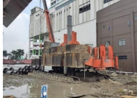
Gambar 3. Proses pemancangan tiang pancang
