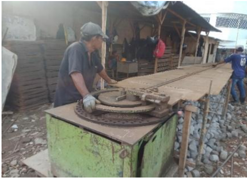
Gambar 8. Pekerjaan pembesian kepala tiang
