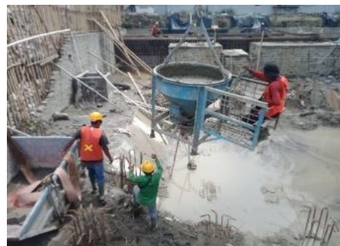
Gambar 7. Pengecoran tiang pancang
