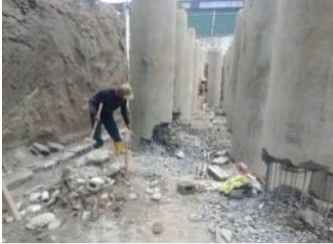
Gambar 5. Proses pembobokan tiang pancang
