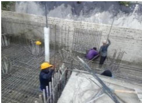
Gambar 9. Pemasangan tulangan kepala tiang
