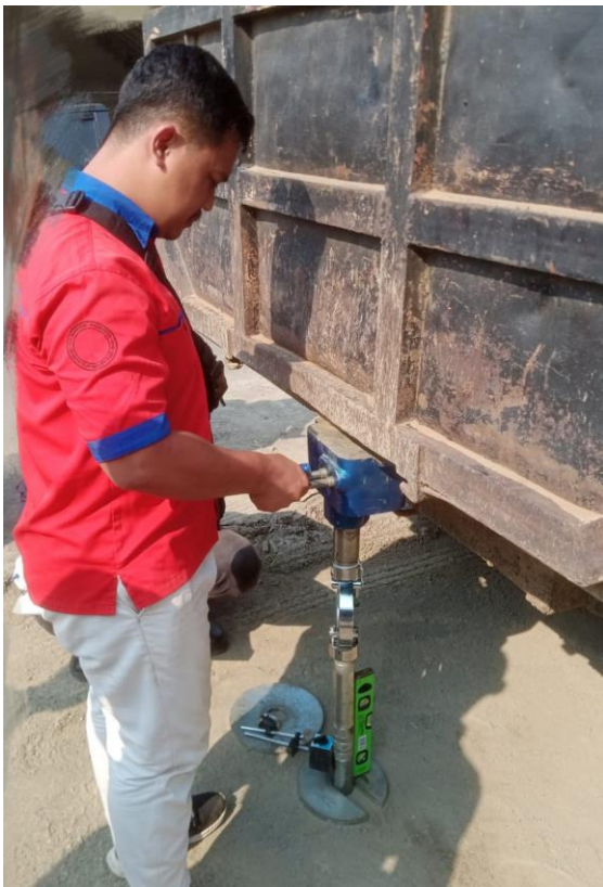
Gambar 4. Uji CBR lapangan
