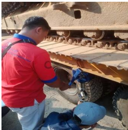
Gambar 8. Uji CBR lapangan
