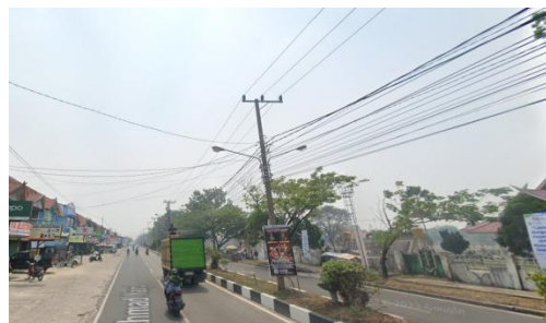
Gambar 7. Kondisi Jalan Ahmad Yani
