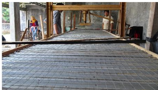
Gambar 12. Pemasangan Wire Mesh Diatas Lantai Ortotropik
