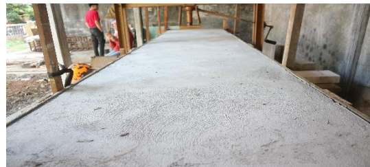
Gambar 15. Pengecoran Lantai
