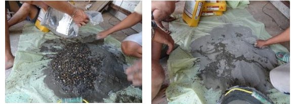
Gambar 14. Pembuatan Beton Sicacrete
