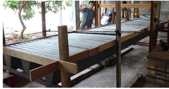
Gambar 13. Pemasangan Bekisting
