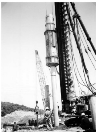
Gambar 2. Sebuah pemancangan tiang pancang di lapangan (Atas izin E. C. Shin, Universitas dari Incheon, Korea)
